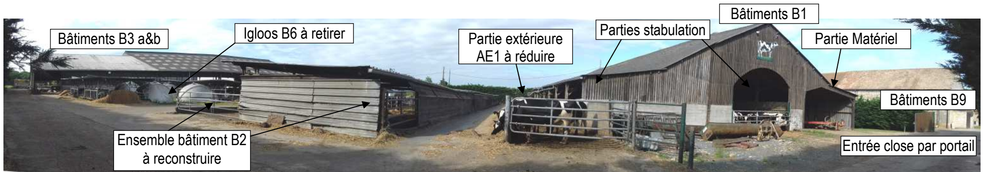
P11 : Vue Nord des bâtiments d'élevage, contre la haie longeant le CR24.
