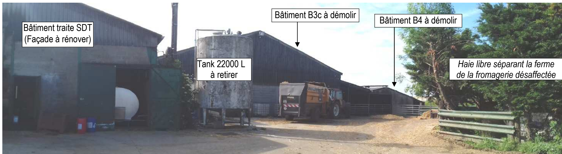
P14 : Vue Nord des bâtiments à démolir ou rénover, depuis la haie longeant la fromagerie désaffectée (pour reconstruction après sinistre nouvelle stabulation B4 370 logettes VL).
