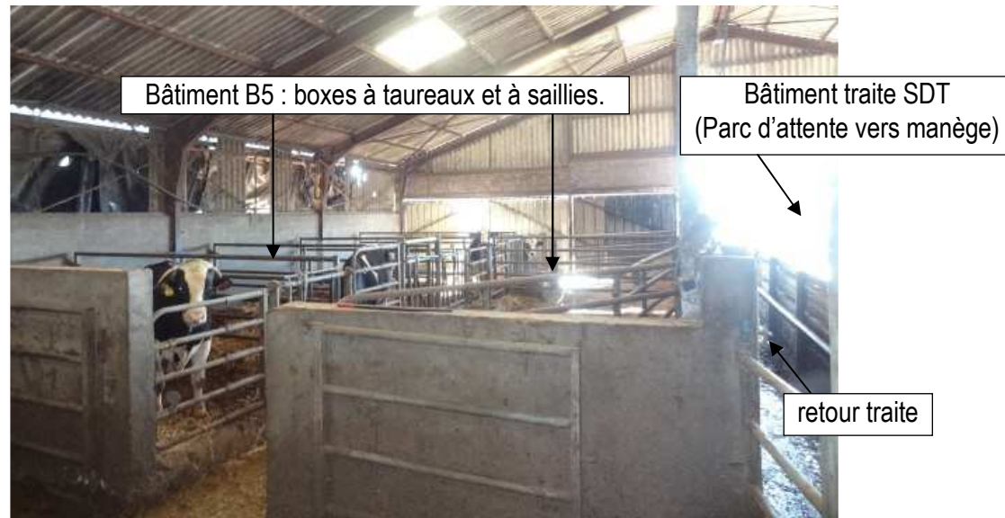
P22 : Vue interne depuis la partie B5 depuis l'intérieur du bâtiment SDT.
