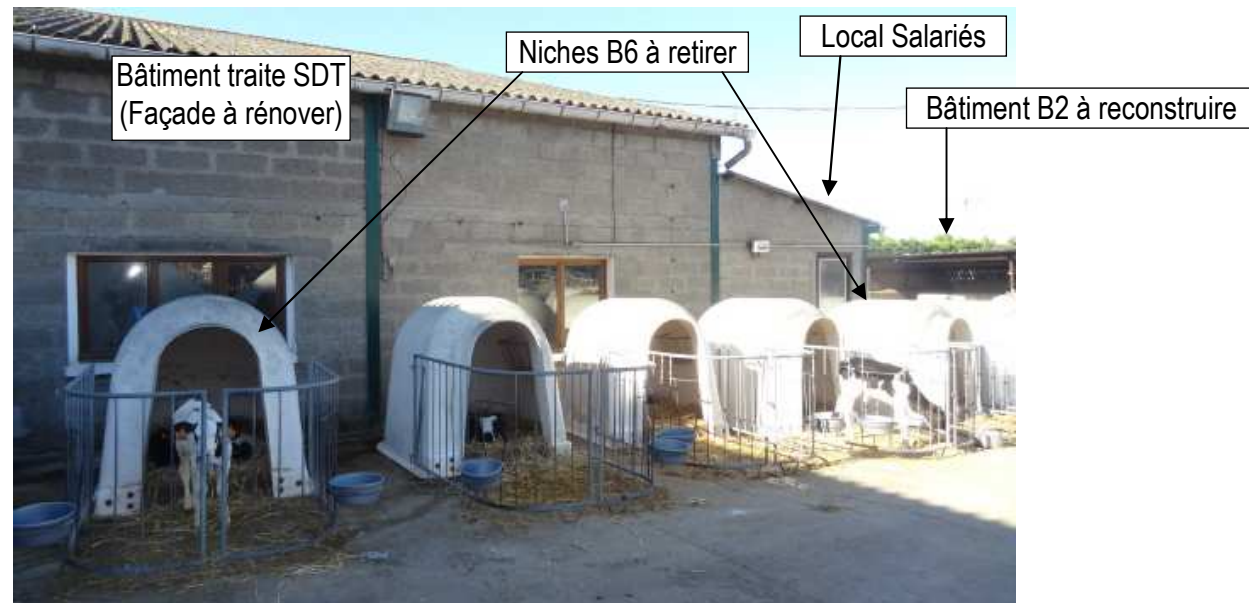
P25 : Vue Nord-Ouest bâtiment SDT et Niches à veaux B6
