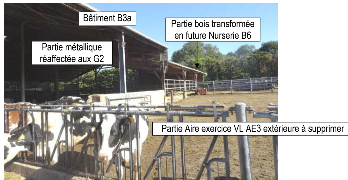
P19 : Vue Sud du Bâtiment B3a et de la partie de l'aire extérieure AE3 à supprimer.
